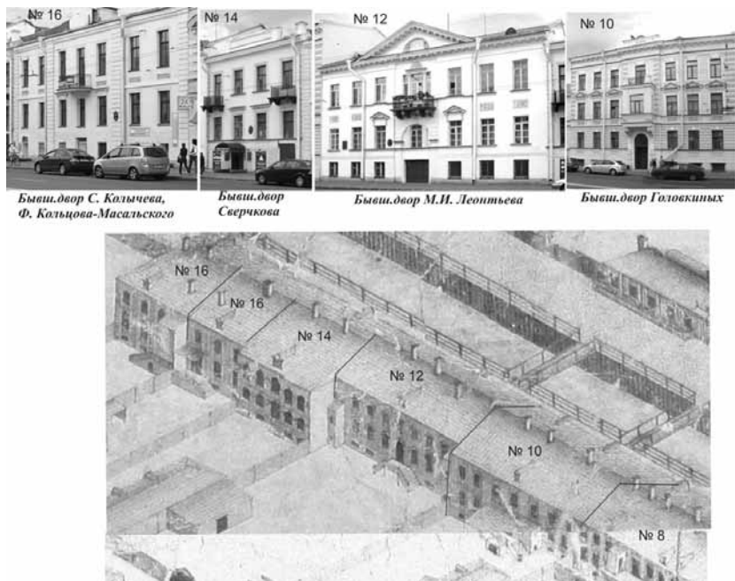
7. Дворы в Первой линии Васильевского острова. Аксонометрический план Санкт-Петербурга. 1765–1773 гг. Л. 36 (137), 25 (126). Фрагмент. Дома № 10–16. Современные фото.
