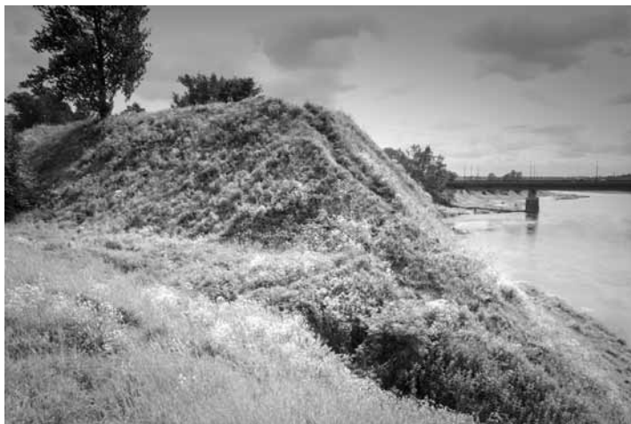
Северо-западный бастион земляной крепости Ямбурга на реке Луге. Снимок 2010 года.
