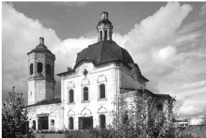
12. Церковь Андрея Первозванного. Вид с юго-востока. Фото У. Брумфилла, 1999.
